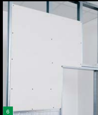
Osadené a zabudované puzdro
