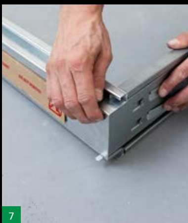
4 Vložte koľajnicu s nadpražím do hornej časti puzdra
