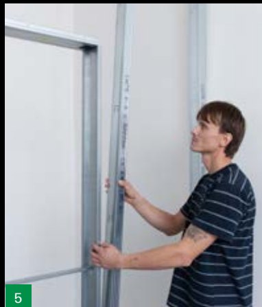
Montáž protiľahlej strany SDK konštrukcie
