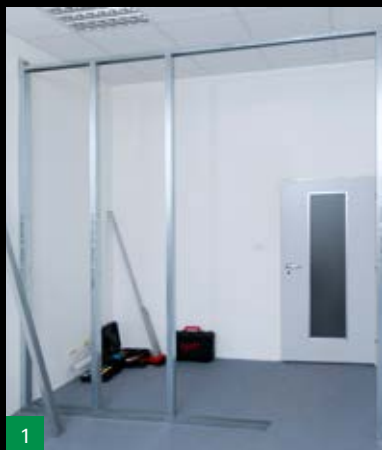
Príprava profilov SDK pre osadenie puzdra
