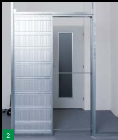
Osadenie puzdra do spodného profilu SDK
